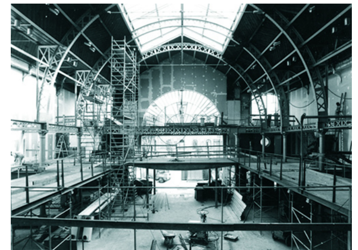
Vue intérieure du pavillon avant sa transformation en musée.
