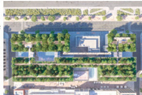
View of roofscape / Vue de la toiture
