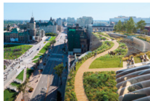
View of roofscape / Vue de la toiture
