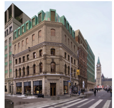
View from Sparks Street and Metcalfe Street / Vue depuis la rue Sparks et la rue Metcalfe
