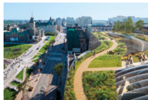
View of roofscape / Vue de la toiture
