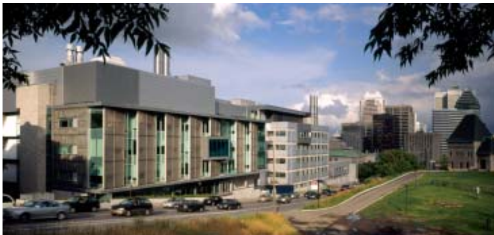
Université McGill et Centre d'innovation Génome Québec | Kuwabara Payne McKenna Blumberg Architects, Fichten Soiferman et Associés, Architectes, architectes en consortium | photo : Tom Arban
